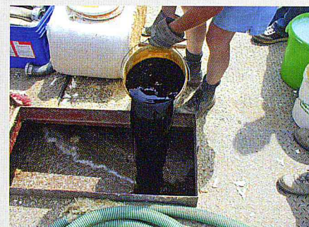
Bild 5: Bodenverbesserungsstoff Alginat
