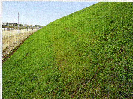
Bild 9: Rohbodenbegrünung nach der Fertigstellungspflege, St. Pölten/Österreich
