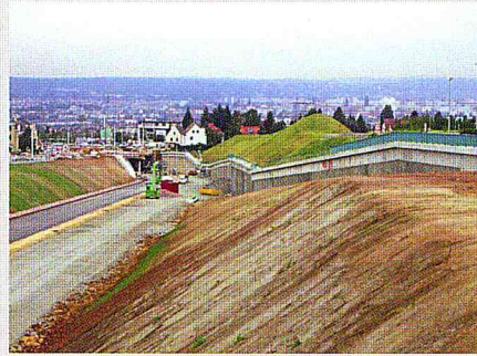
Bild 1: Beispiel vorgefertigte Böschung, im Hintergrund begrünete Fläche, Dresden
